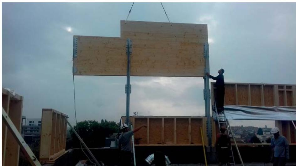
Du point de vue du respect de la réglementation ERP et sécurité incendie, la solution a été de faire tous les murs porteurs et planchers en CLT (contre-latté) d'épaisseur 20cm. La structure est ainsi stable au feu pendant 1h.
