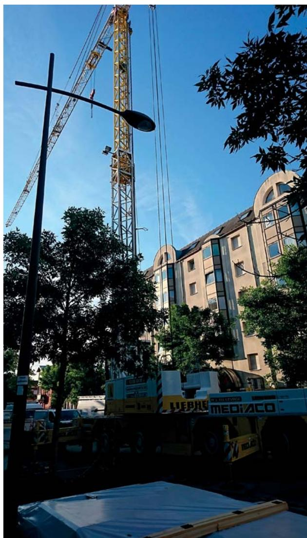
La construction initiale en ossature béton, avait, dans son système constructif et ses fondations, été conçue et réalisée en prévision d'une surélévation en ossature béton. Il en était de même pour tous les réseaux de distribution et de chauffage.
